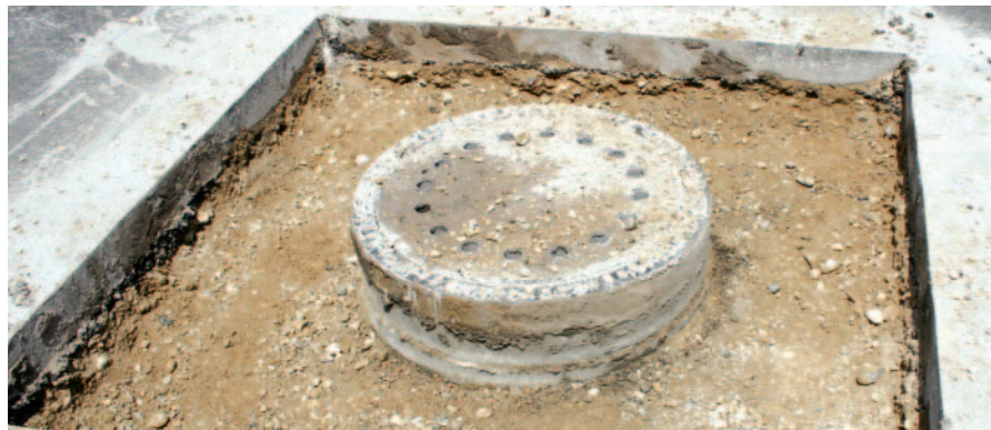
Der flexible Kunststoffring, das Herzstück des Niveausgleichssystems ANA
